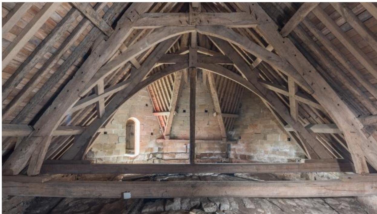
Vue de la charpente du choeur depuis l'ouest.
