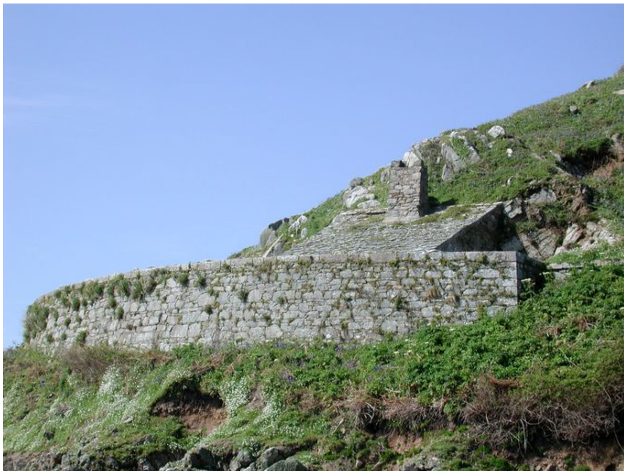
Vue générale depuis la cale orientale (état en 2002)
