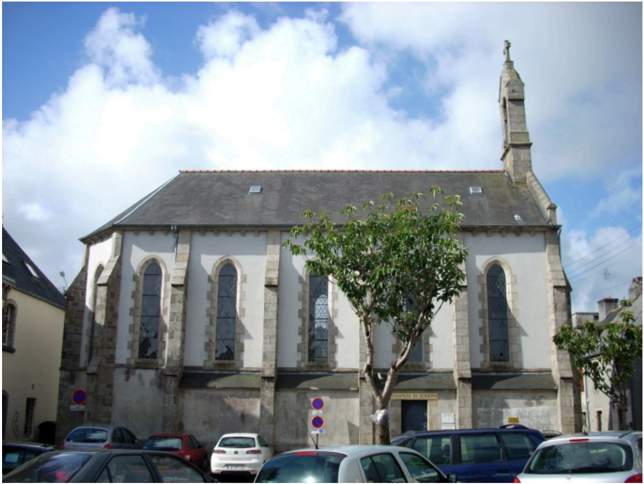
Lesneven, chapelle Saint-Joseph : élévation nord
