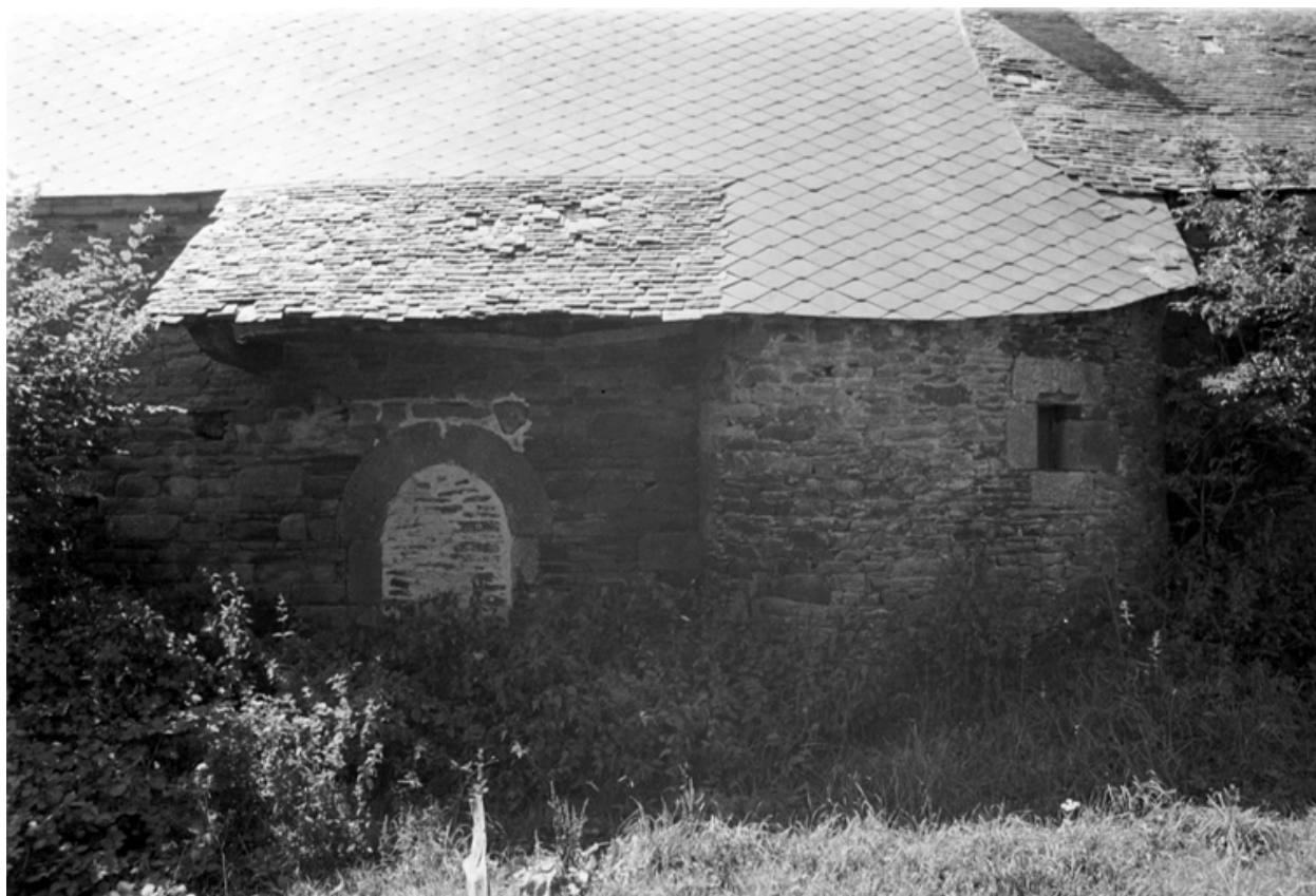
Façade nord : détail de la tourelle
