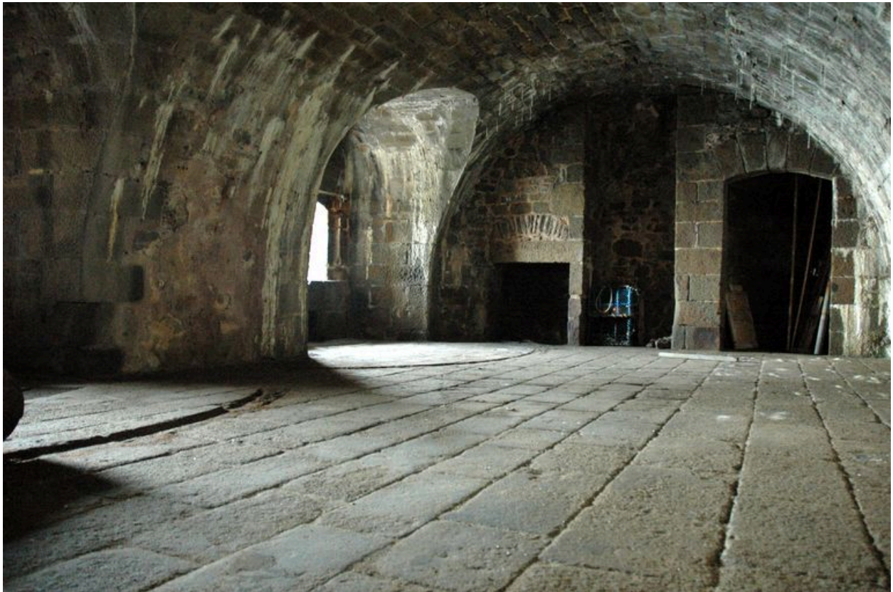
Vue du fort de la Conchée : corps de garde de la garnison dit souterrain à deux embrasures
