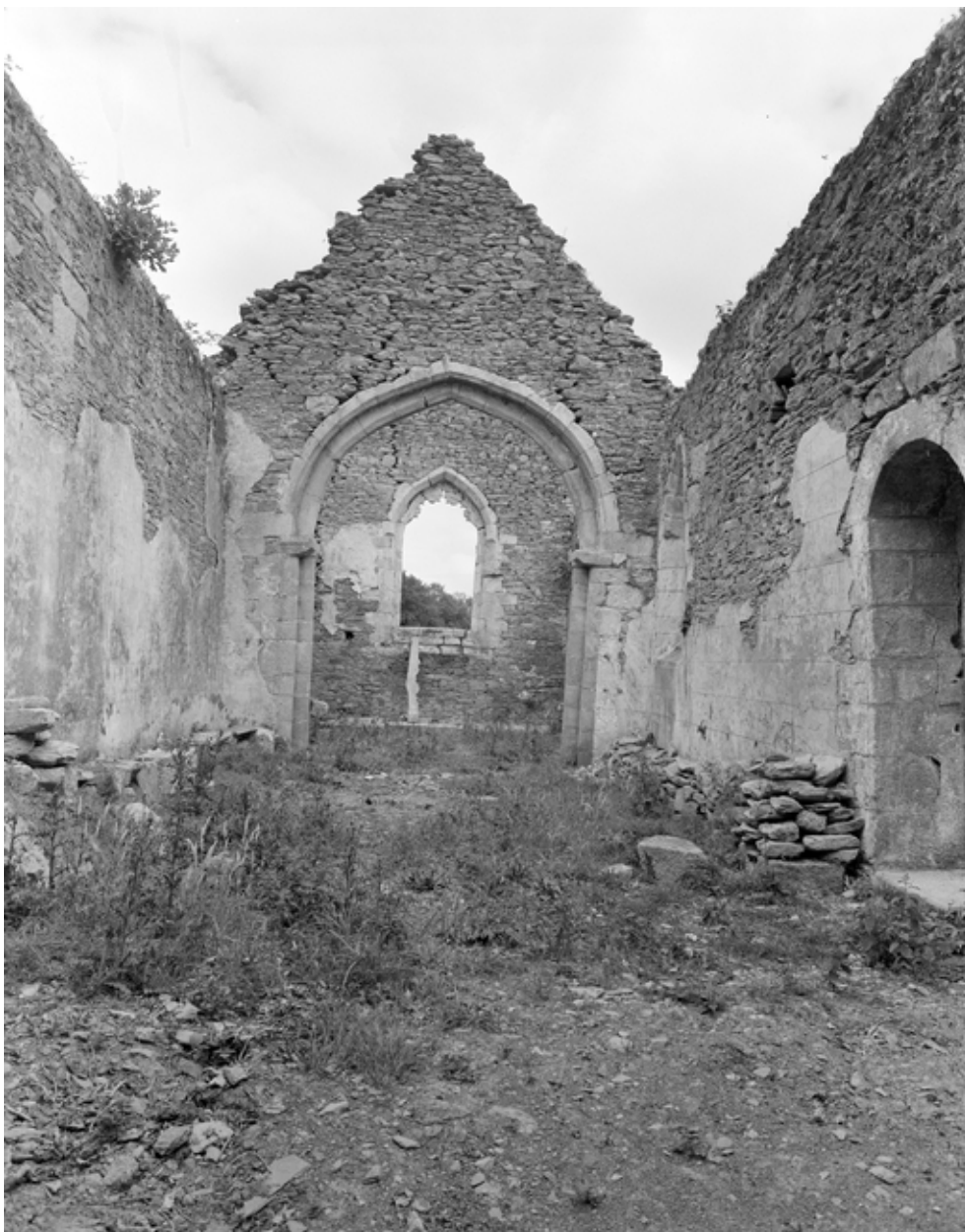
Vue intérieure de la nef et ducjhoeur prise d'ouest en est
