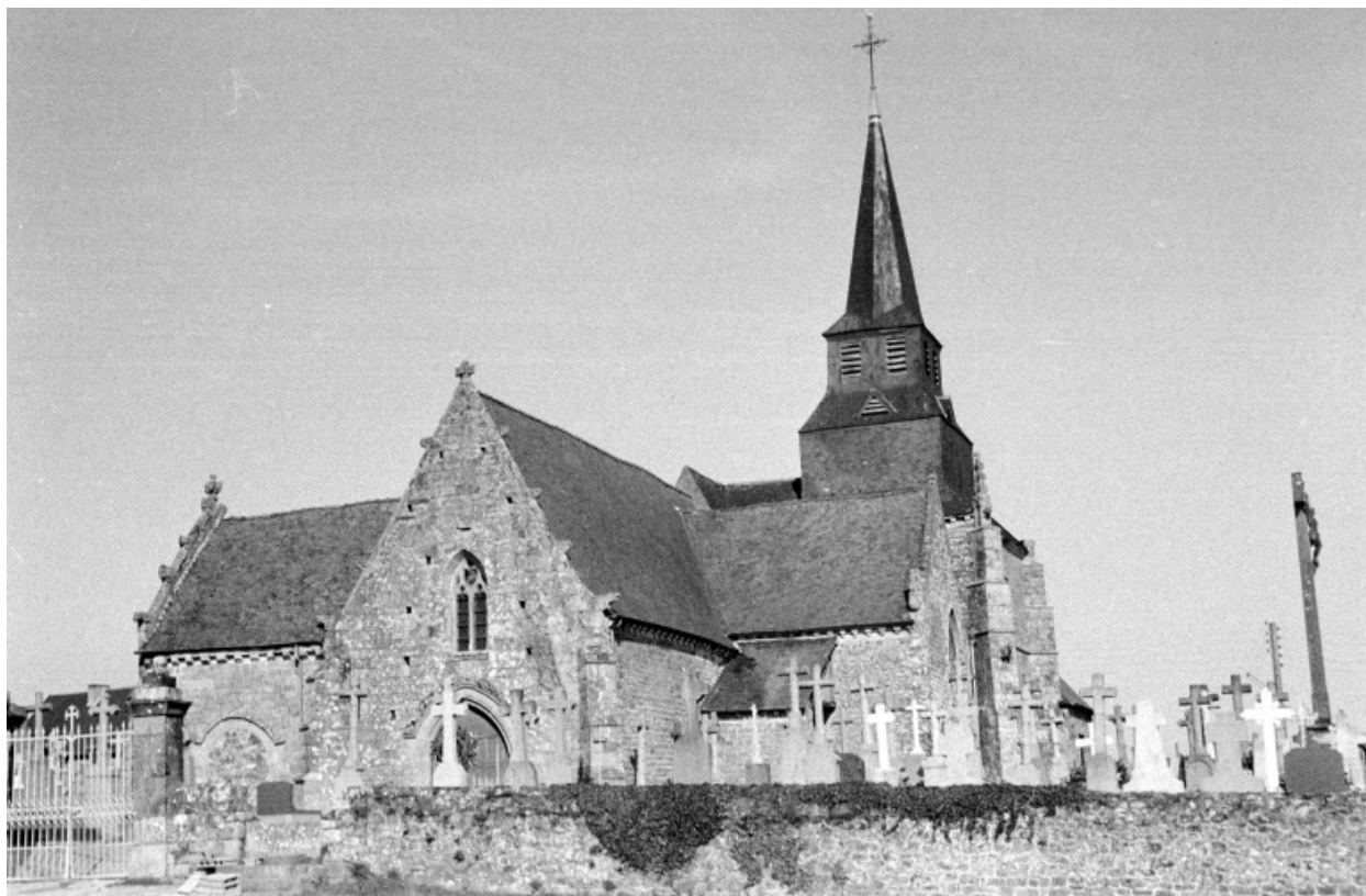
Vue d'ensemble sud-ouest
