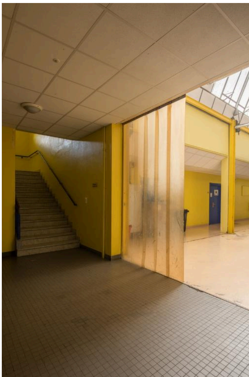
Cage d'escalier, bâtiment G, Ateliers. Albert Hec et Roger Besnard, architectes, 1969.
