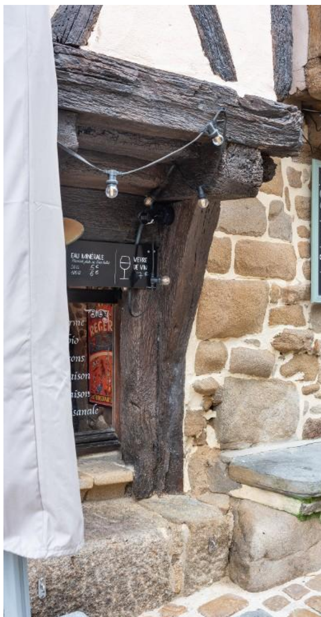
Poteau cornier droit, au rez-de-chaussée.
