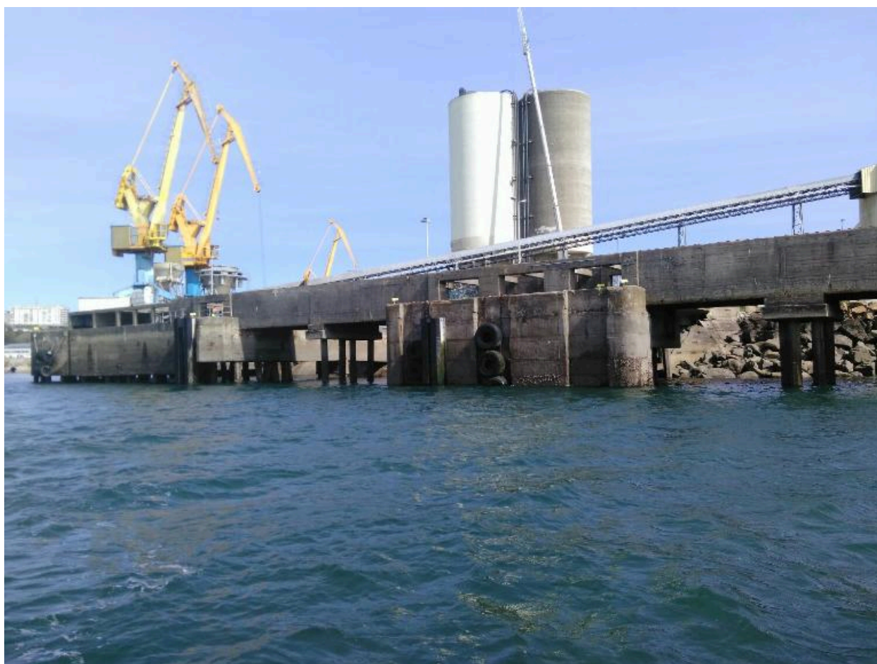
Quai des caboteurs
