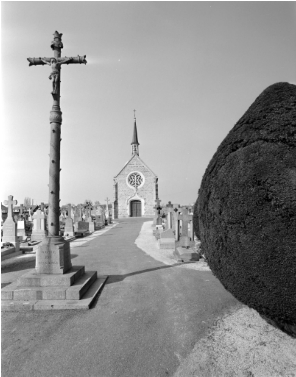
Elévation ouest : vue de situation
