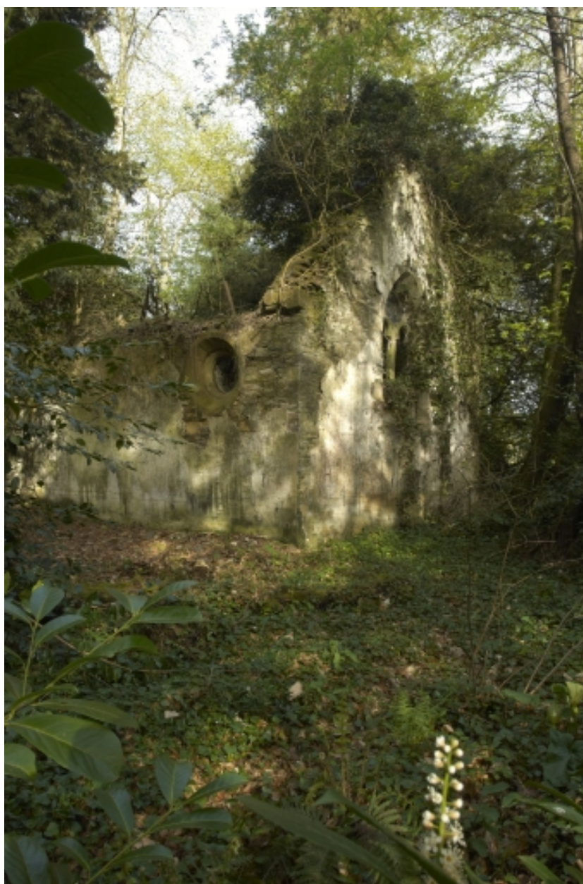
Chapelle, vue générale extérieure
