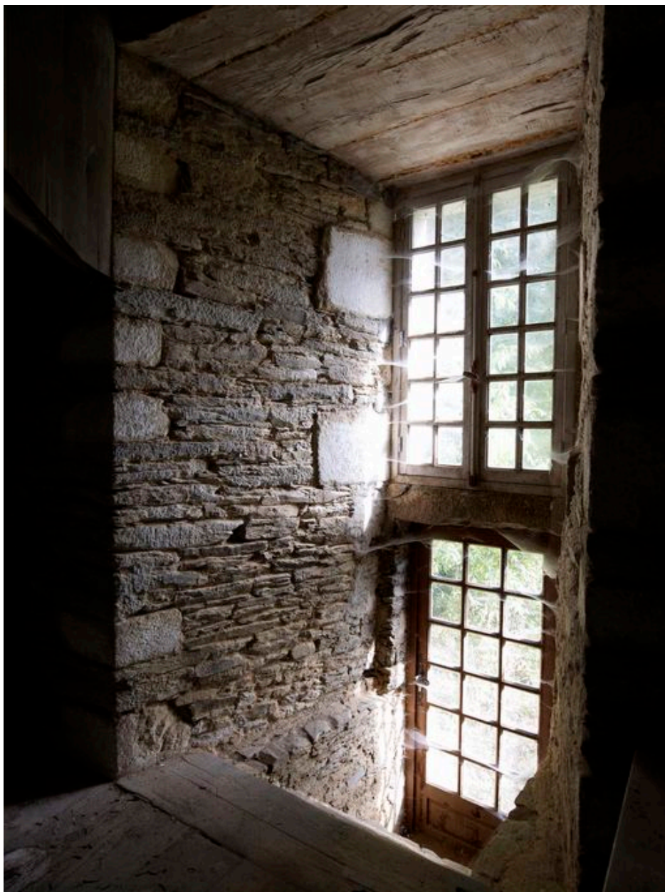
Château, tour isolée nord-ouest, rez-de-chaussée : fenêtre ouvrant vers le sud (état en 2010)
