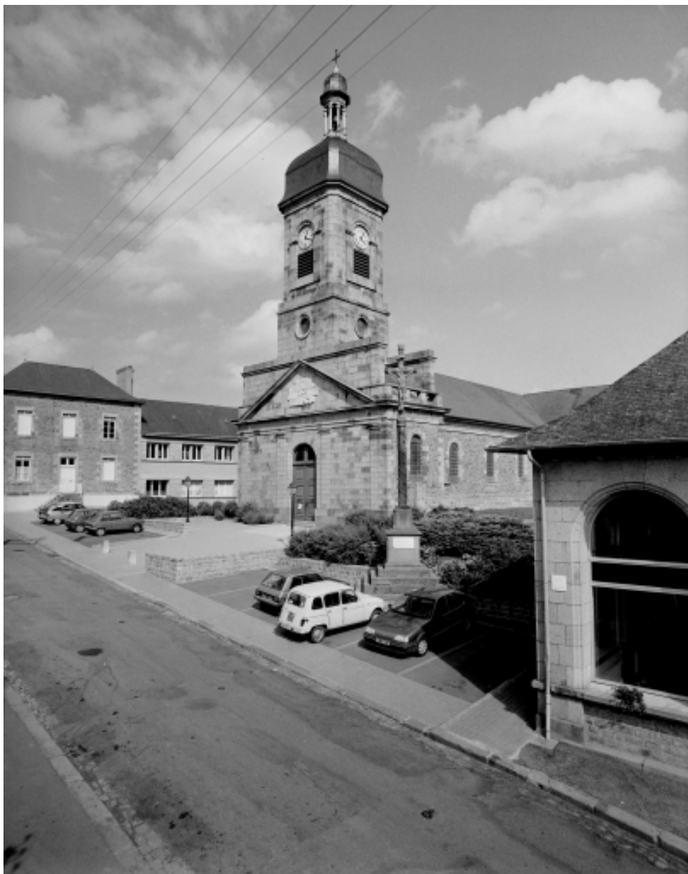
Elévation Ouest : vue générale
