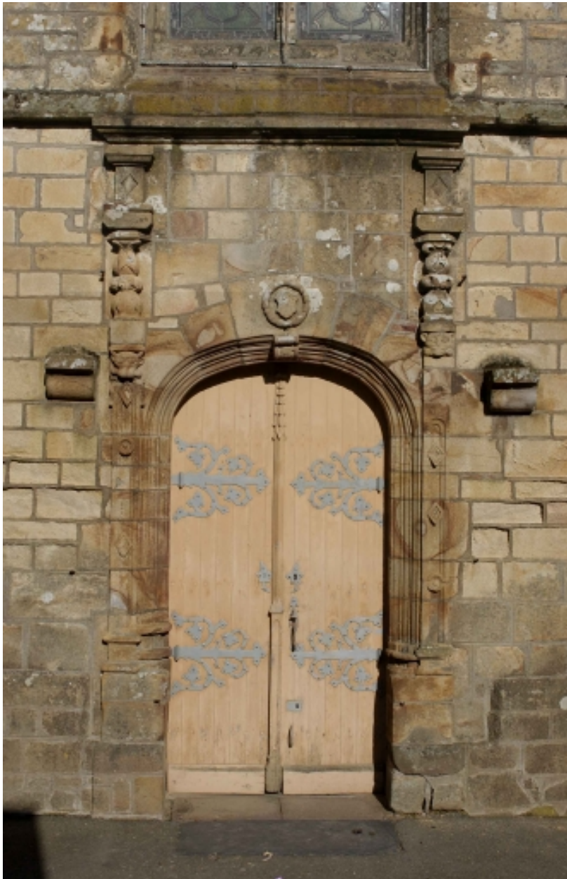
Façade sud, détail, porte des fidèles
