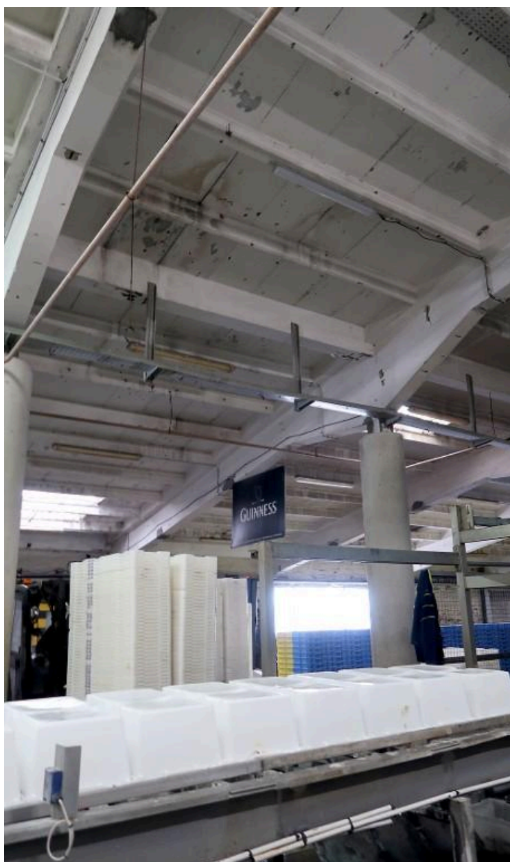
Charpente en béton armé de la criée de Keroman
