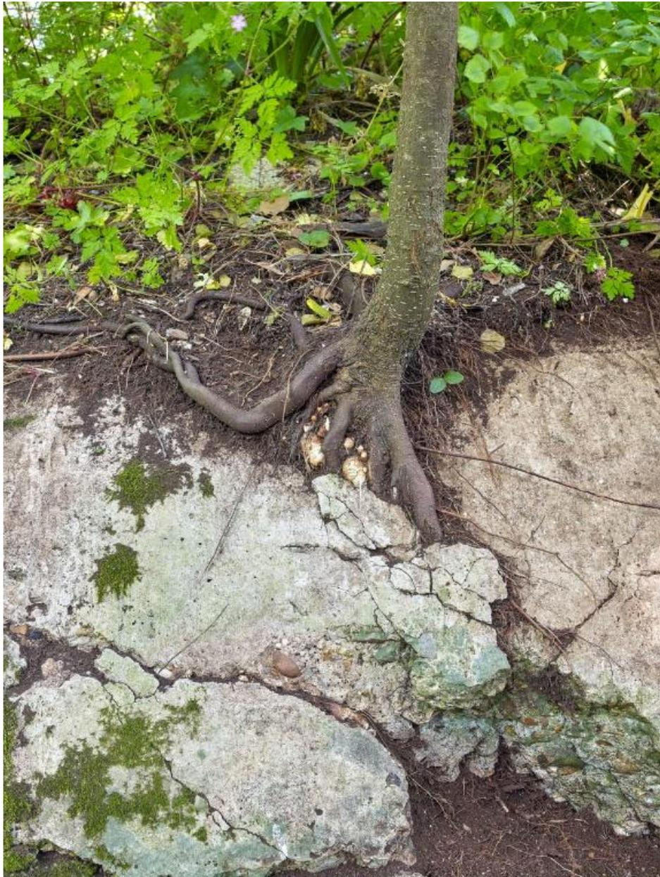
Vue des racines d'un arbuste profitant d'une fissure dans le béton... Dalle de couverture et murs périphériques mesurent 2 m d'épaisseur. Le béton armé a pourtant été fissuré par l'explosion interne
