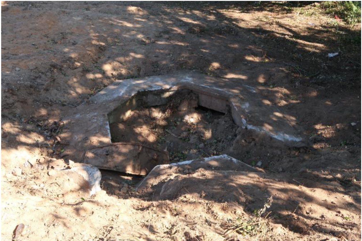
Vue générale (août 2022, chantier en cours)
