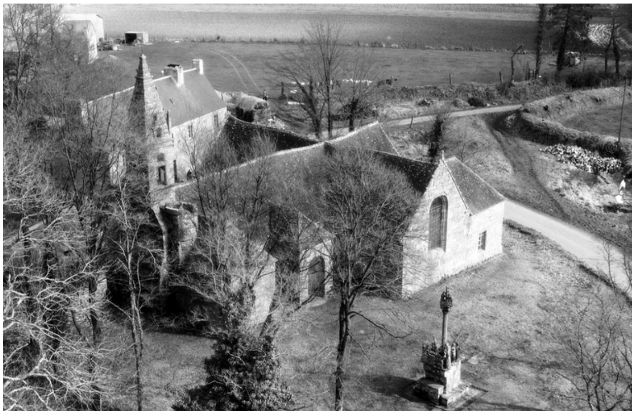
Vue aérienne prise du sud-ouest
