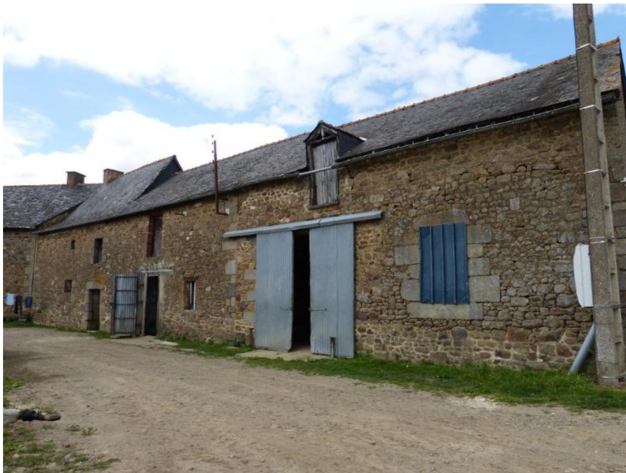
Vue générale sud, ferme, Bêlême (Hédé-Bazouges)
