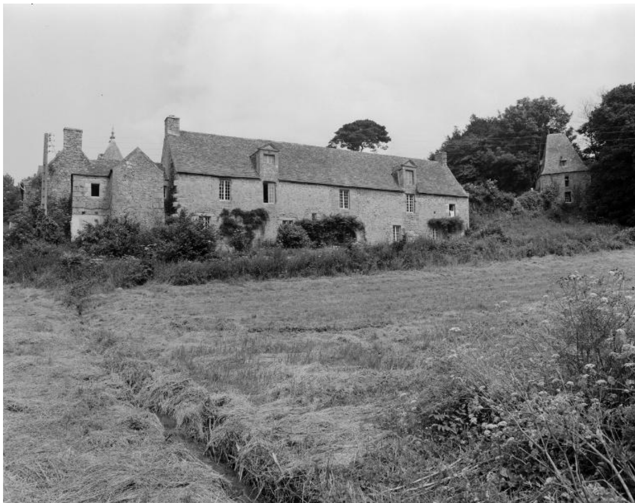
Aile des communs, élévation ouest
