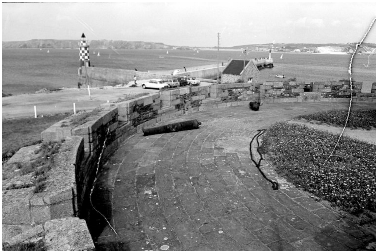
Vue de batterie de la tour Vauban en 1969
