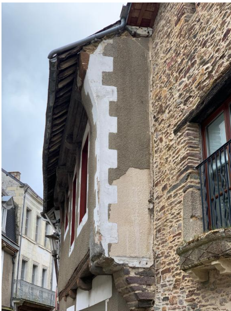
Elévation sud, vue de l'encorbellement
