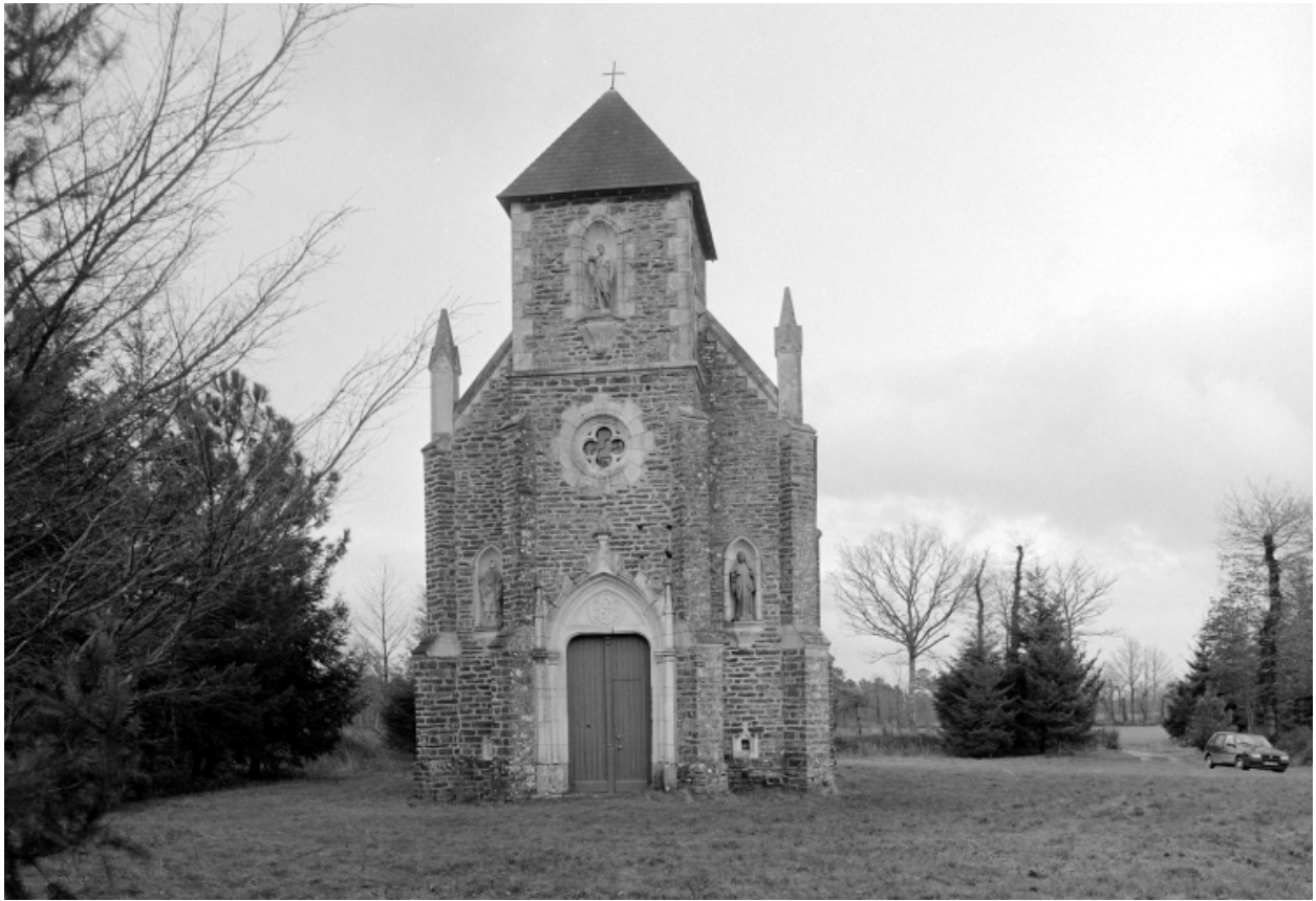
Elévation Ouest : vue générale
