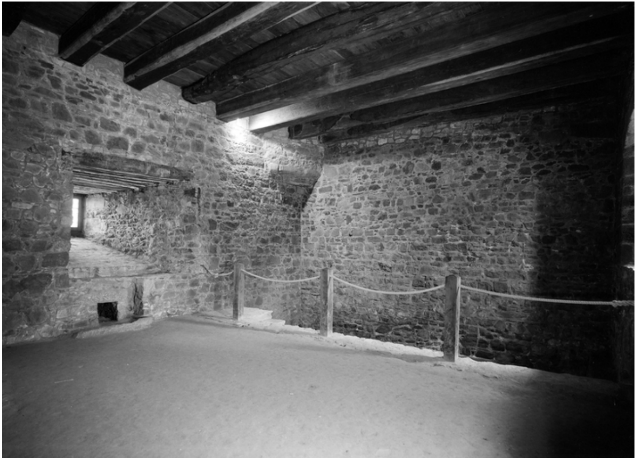
Vue du cellier : mur gouttereau postérieur et angle sud-est (état en 1974). Le cellier est doté de deux niveaux
