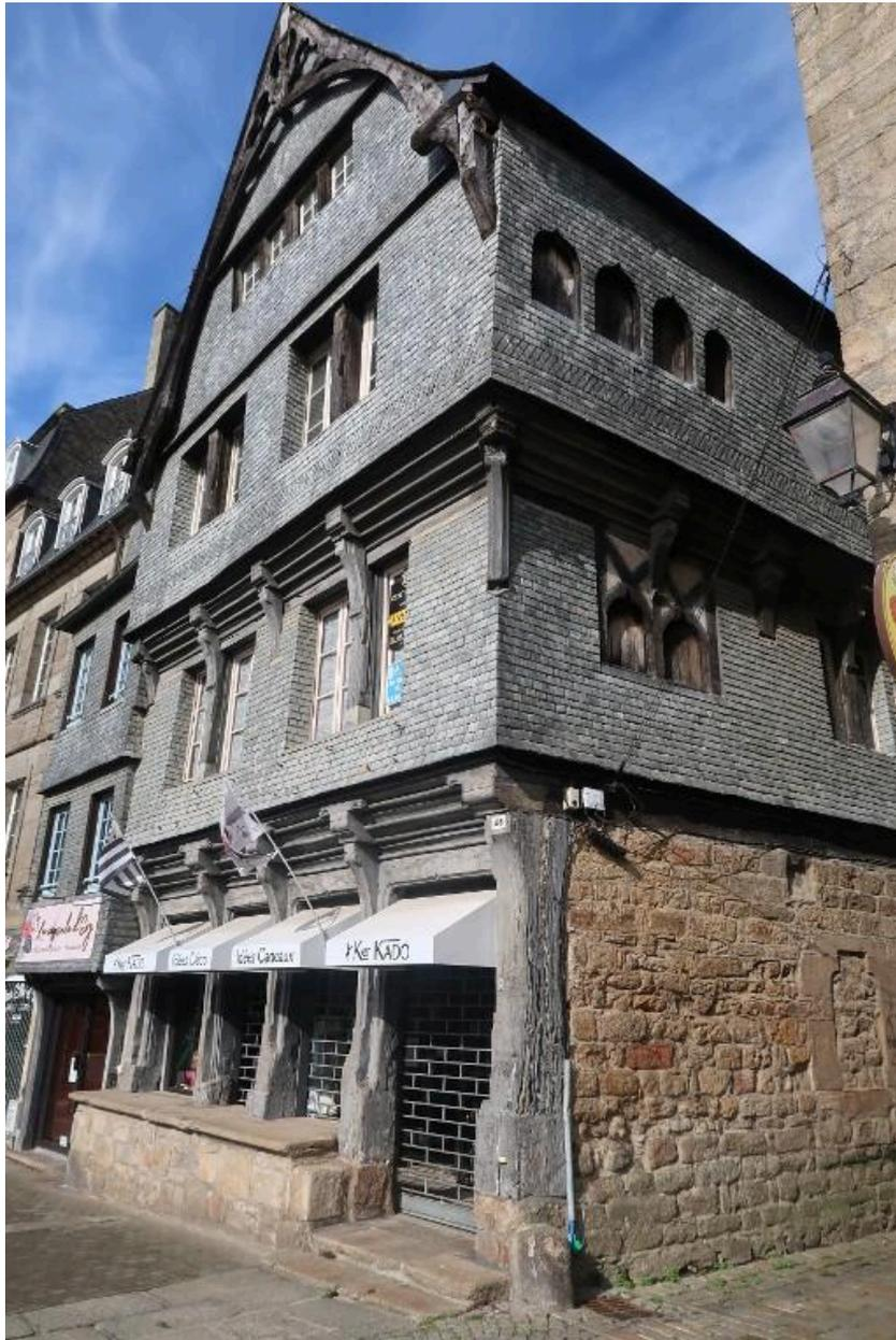
Maison d'angle de construction mixte en pan de bois et maçonnerie.
