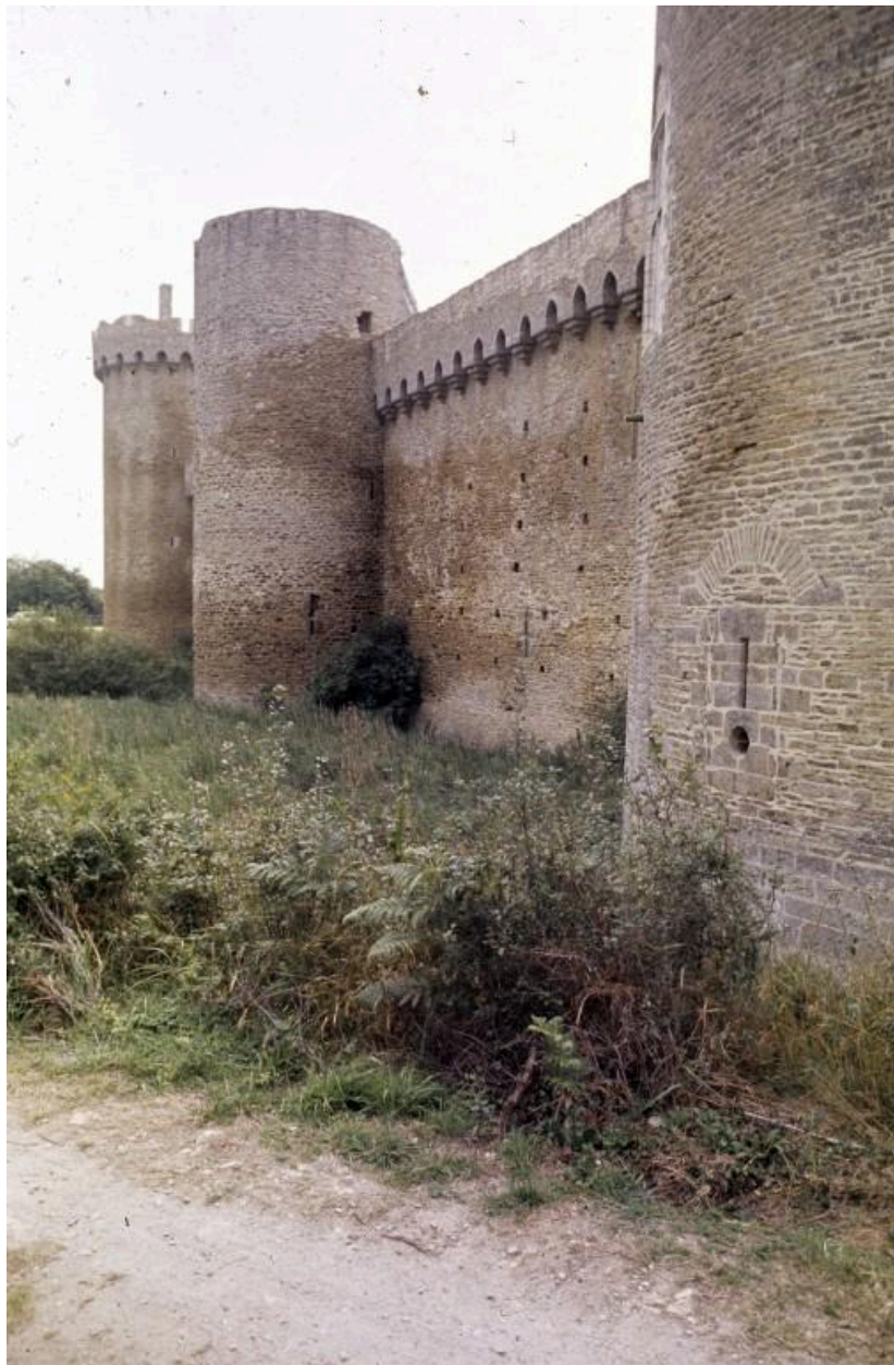
Courtine nord, vue prise de l'ouest
