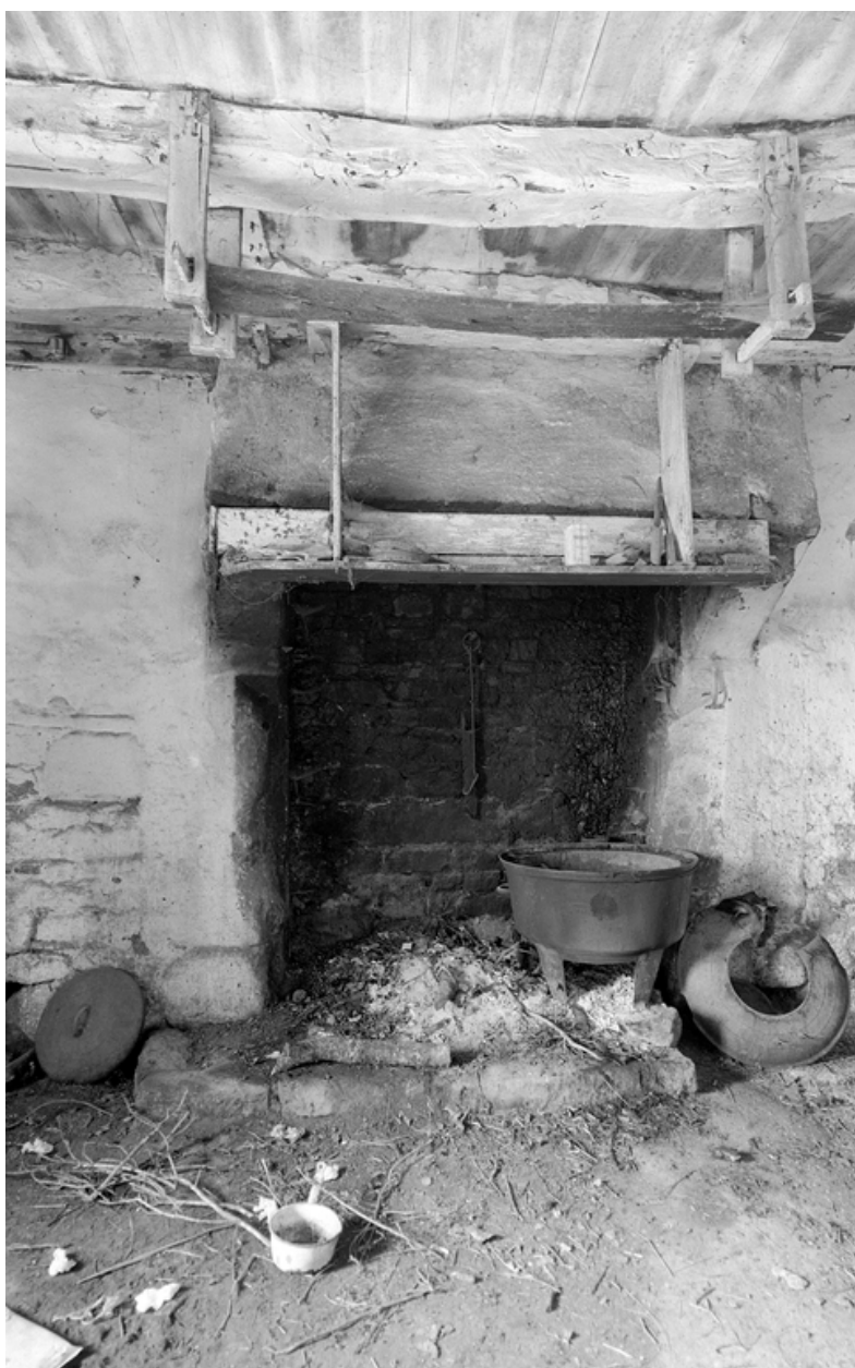
Cheminée de la pièce ouest du rez-de-chaussée du logis
