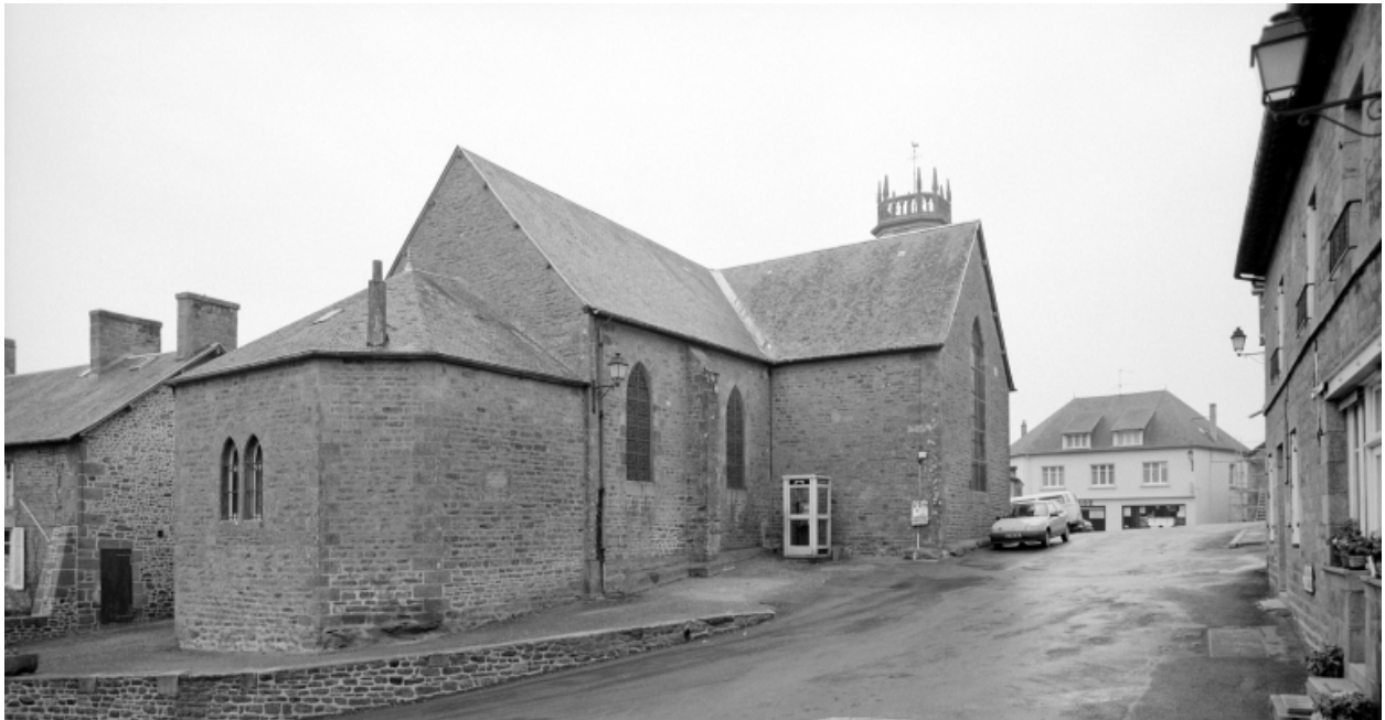
Elévation Nord-Est : vue générale
