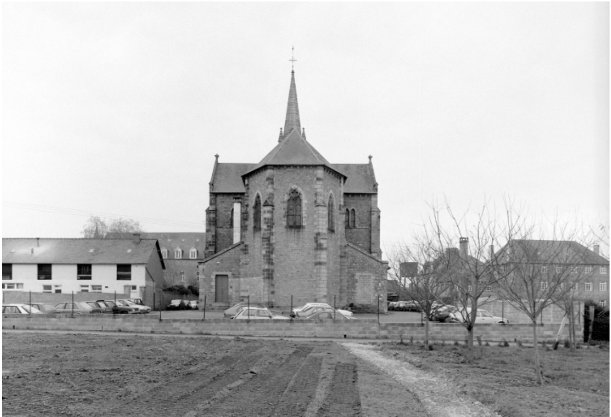
Elévation Ouest : vue générale
