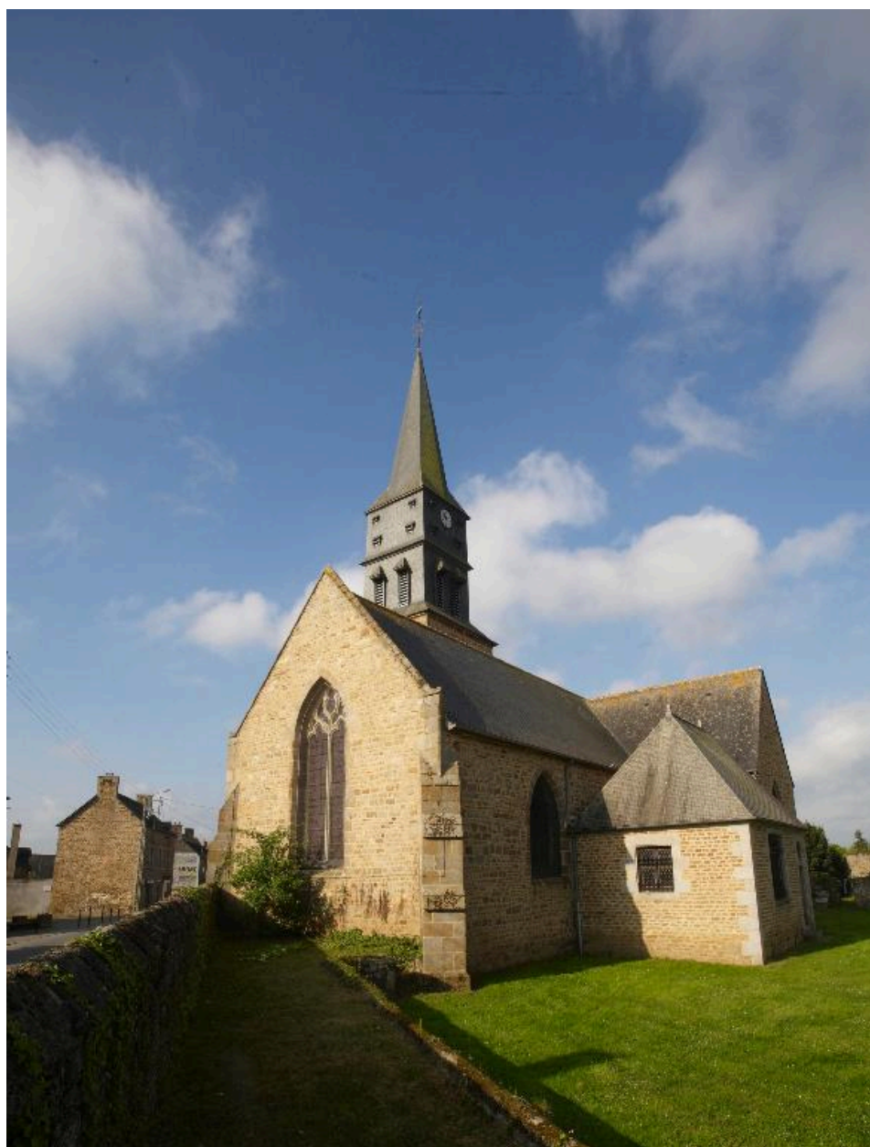
Vue générale : côté nord-est
