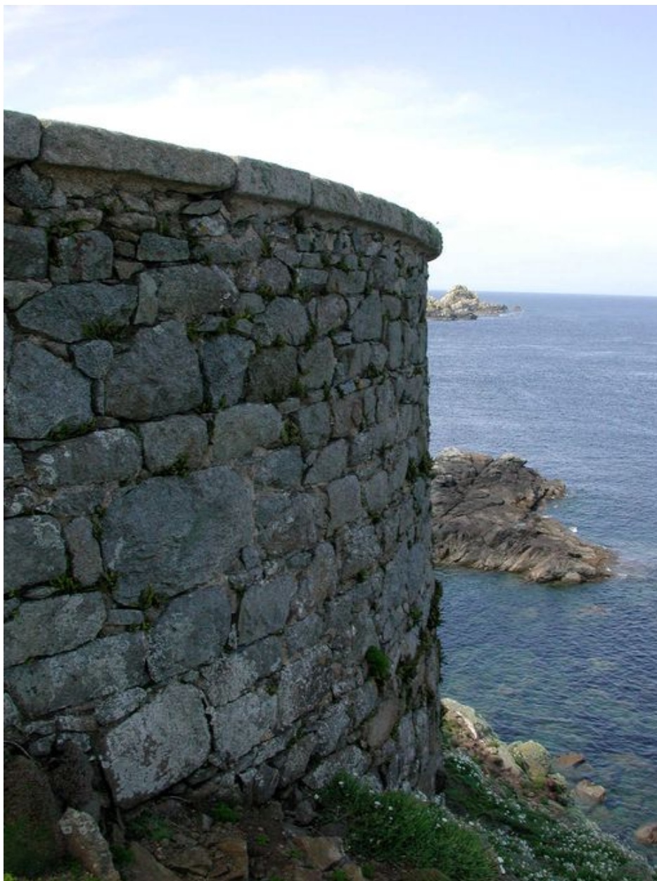
Vue de la batterie de la Théroute depuis le nord
