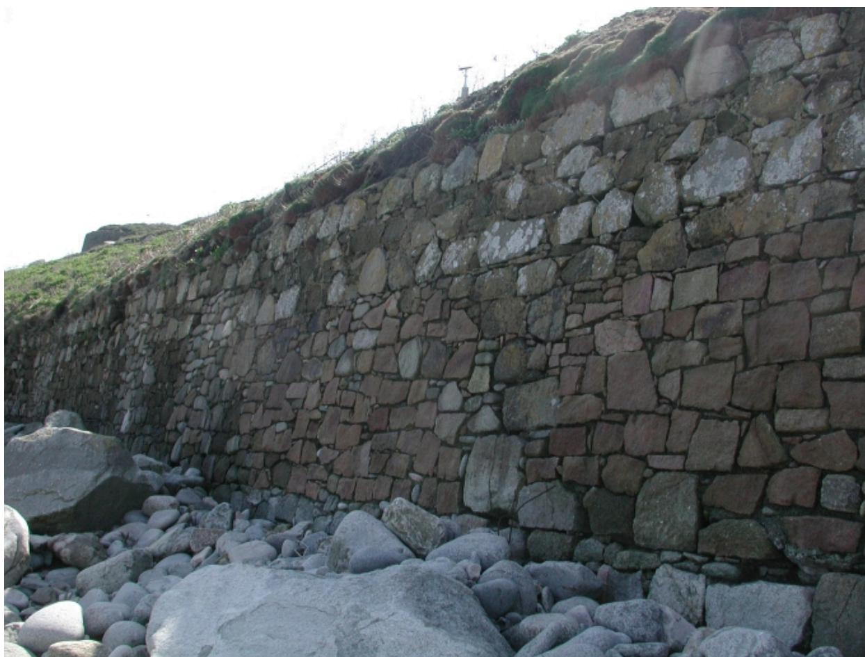
Murs de soutènement du talus refaits en 1999, côté est
