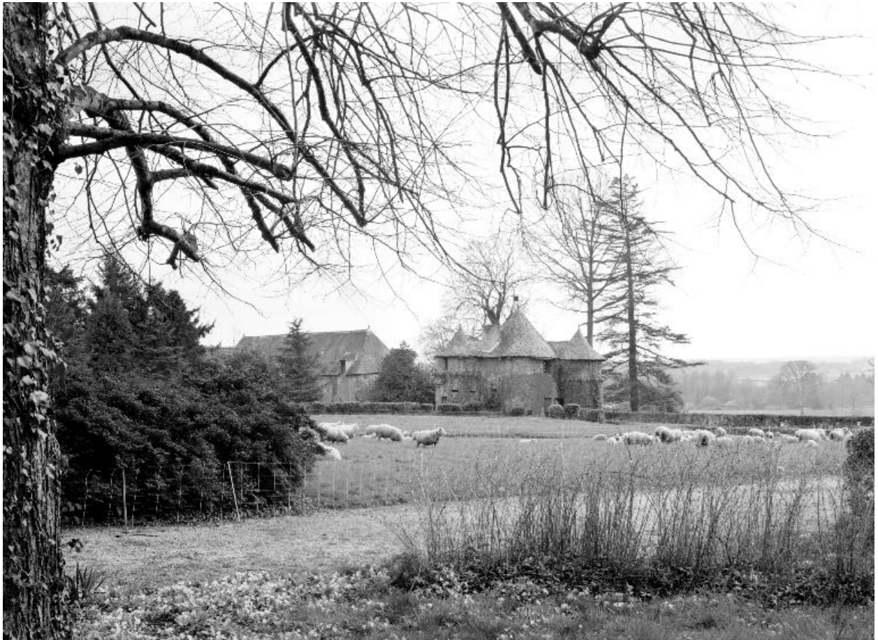
Château, tour sud-est, vue générale nord-ouest.
