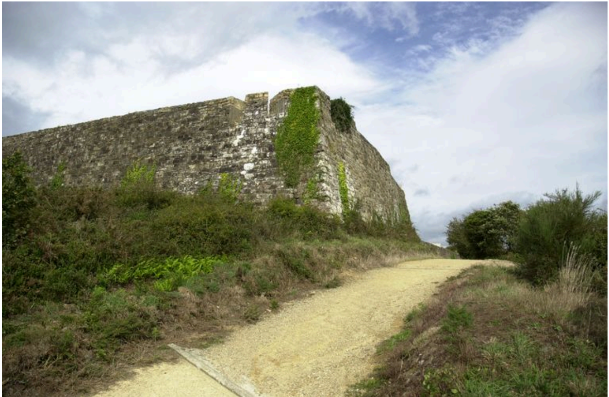
Vue du fort de Lanvéoc : demi-bastion est, embrasures bétonnées
