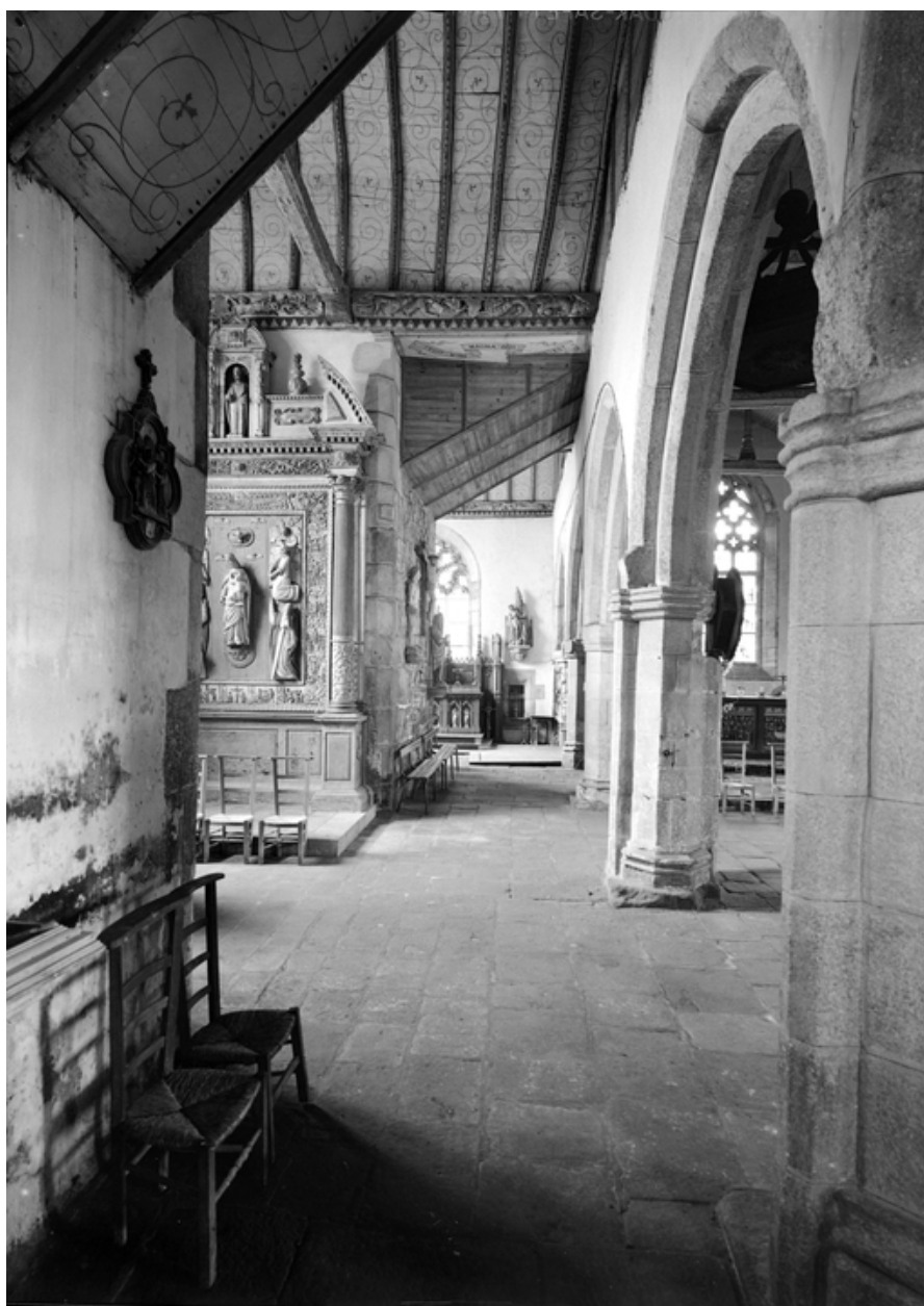
Vue axiale du bas-côté nord de la nef
