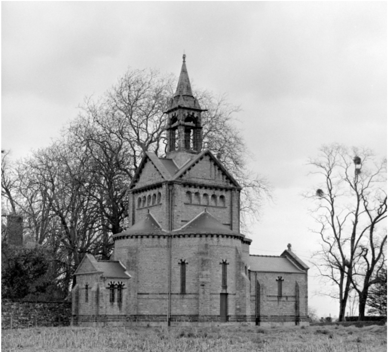
Elévation ouest : vue de situation
