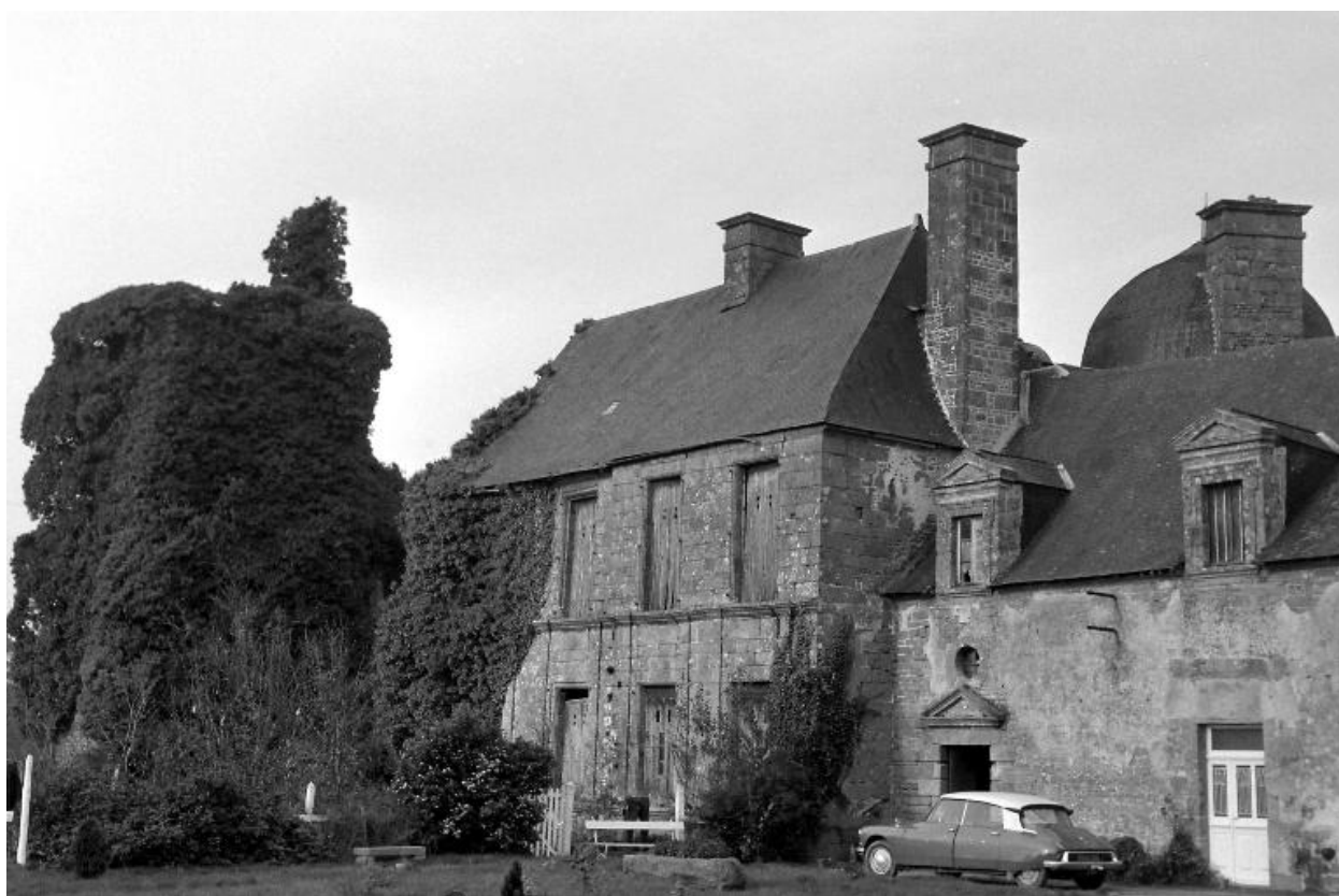
Façade sud ouest avec tour carrée sous le lierre
