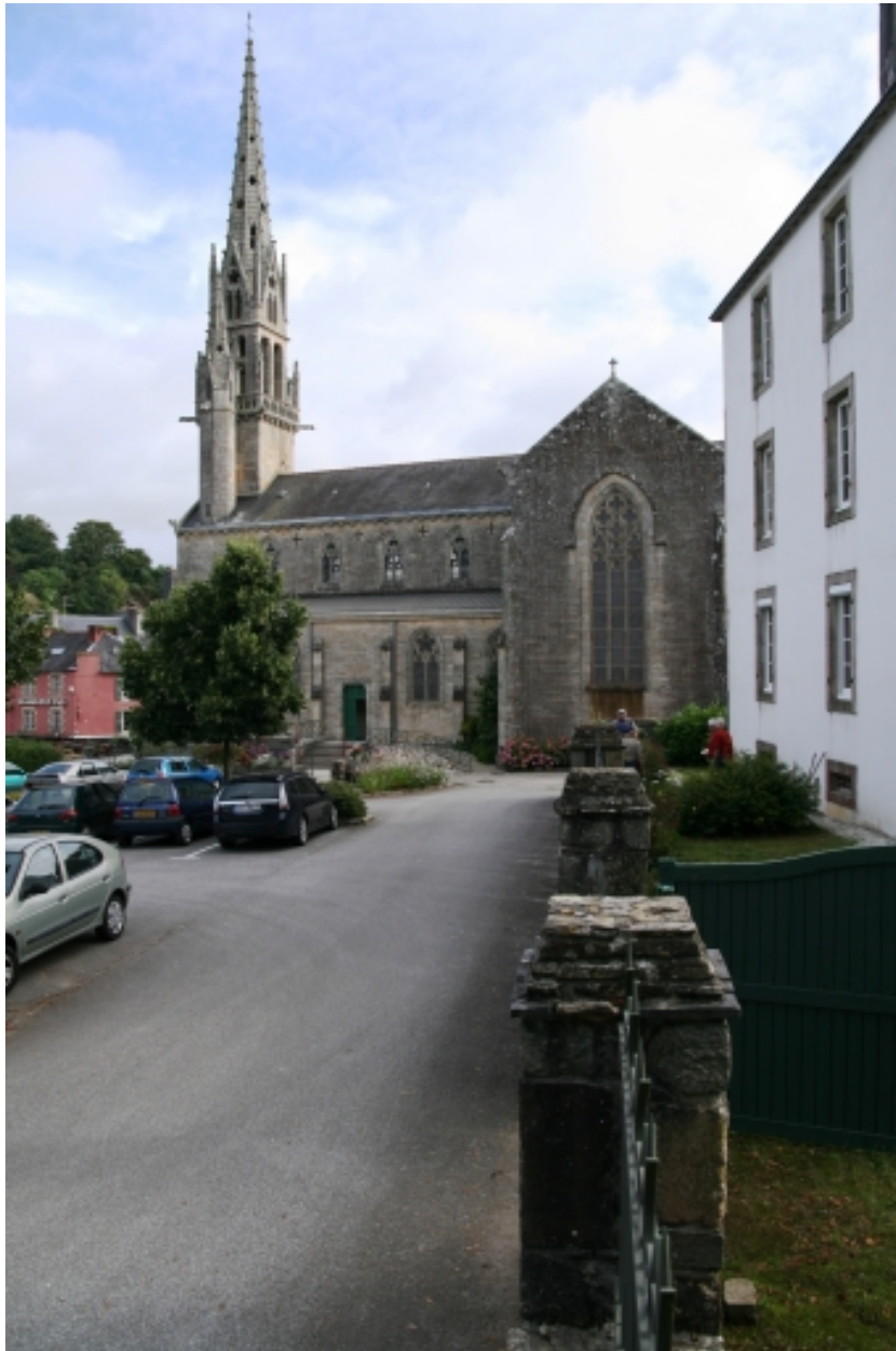
Châteaulin, église paroissiale Saint-Idunet : vue générale sud
