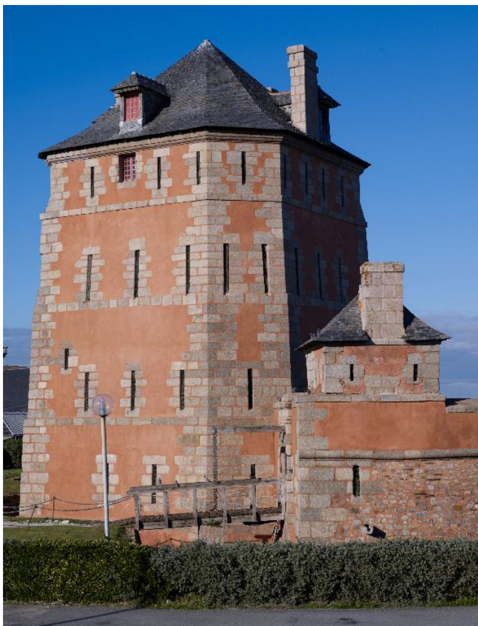
Camaret-sur-Mer : vue de la tour Vauban
