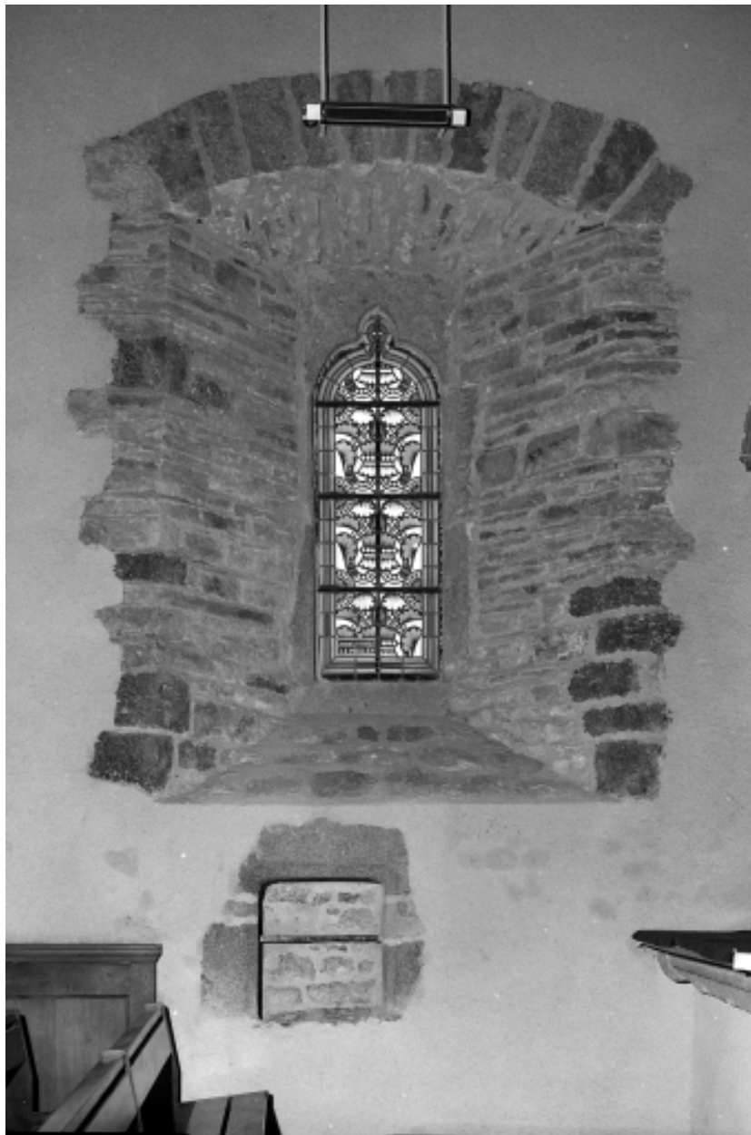
Mur nord, fenêtre et niche, vue générale.
