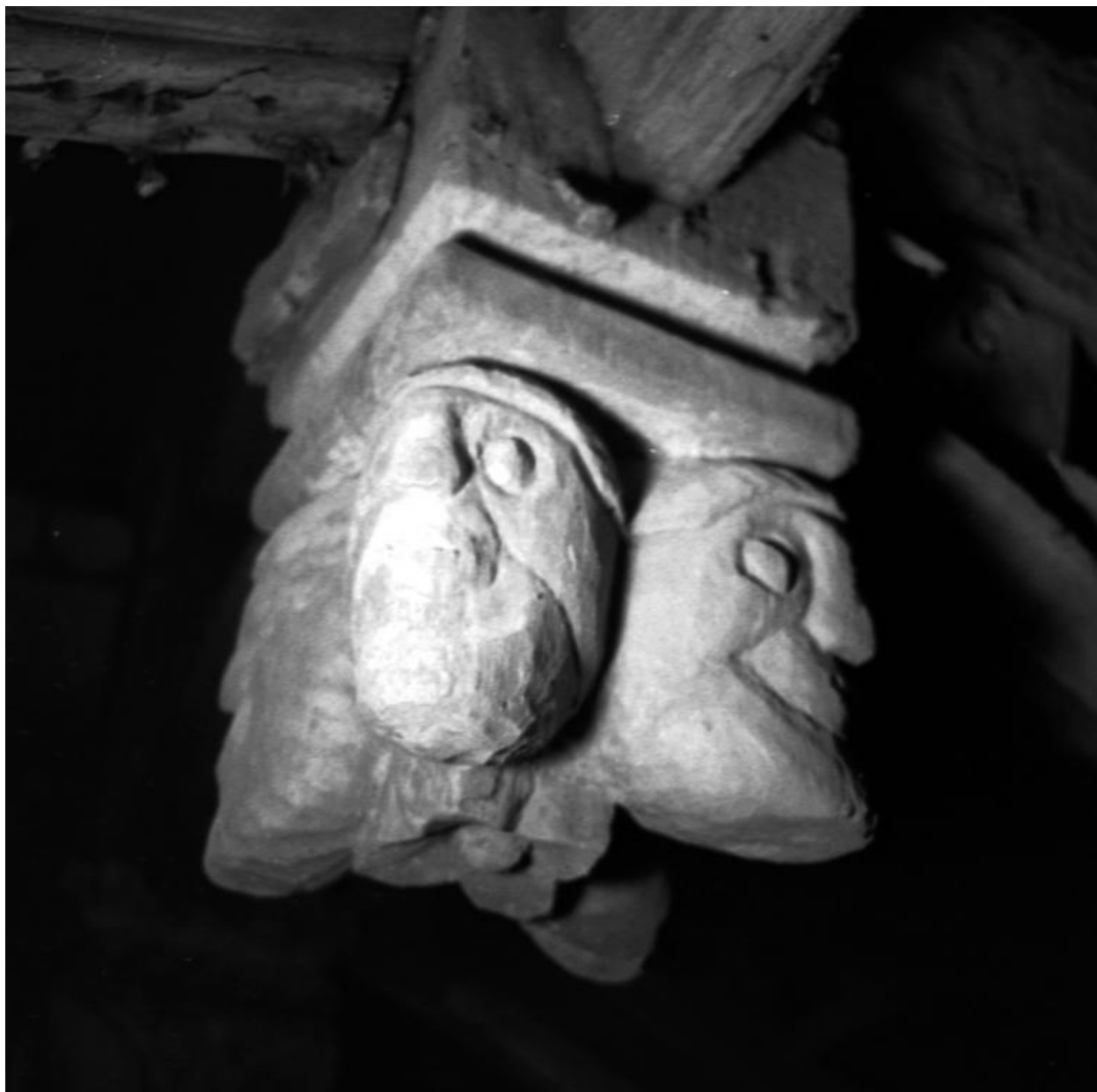
Charpente, détail de la clé 11.
