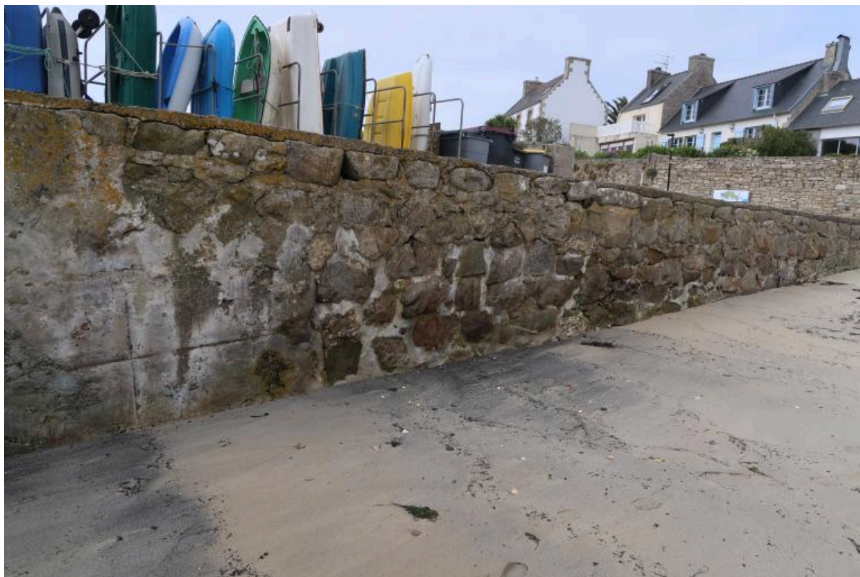
Cale de Porz Kernog, côté est : traces des différentes interventions de travaux
