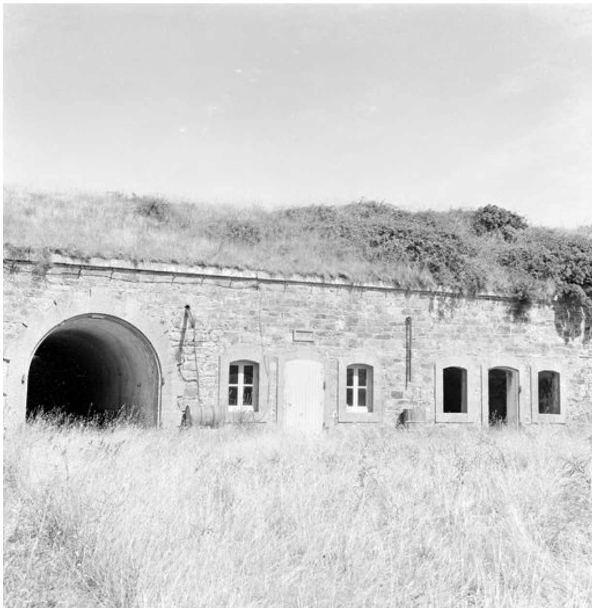
Vue du passage couvert et des casernements (état en 1969)
