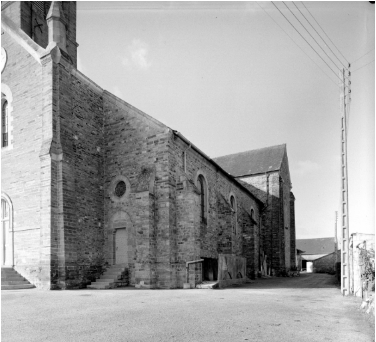
Elévation Sud : vue générale
