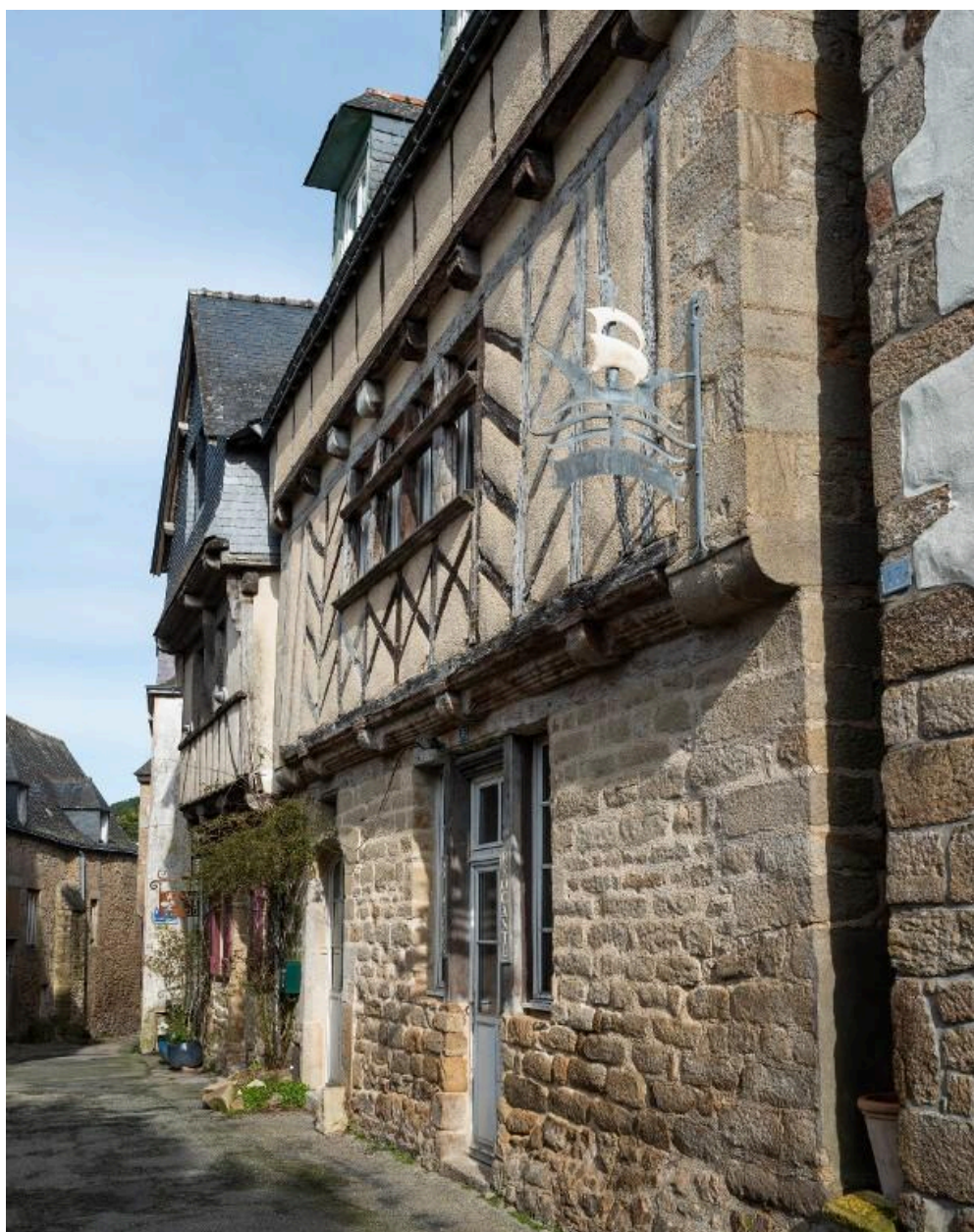
Façade à gouttereau sur rue, rez-de-chaussée maçonné, étage et surcroît en pan de bois.
