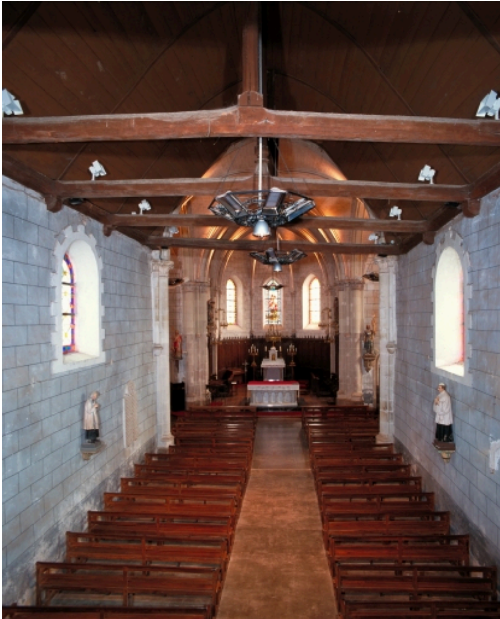
Vue intérieure prise de la nef vers le chœur
