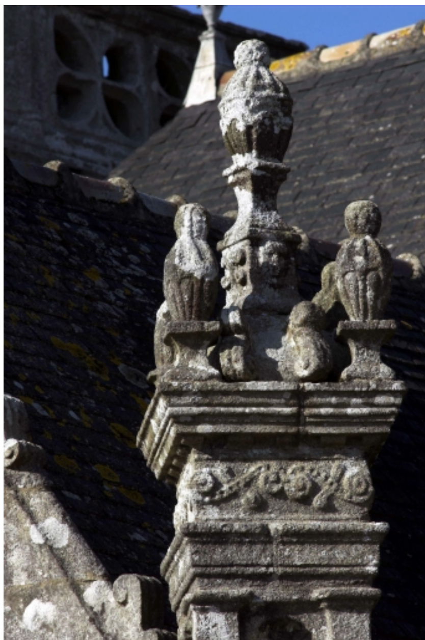
Porche, contrefort est, amortissement
