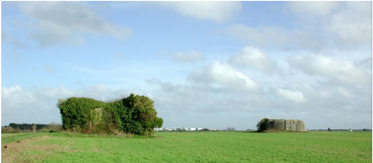
Vue générale des deux casemates est (état en 2002)
