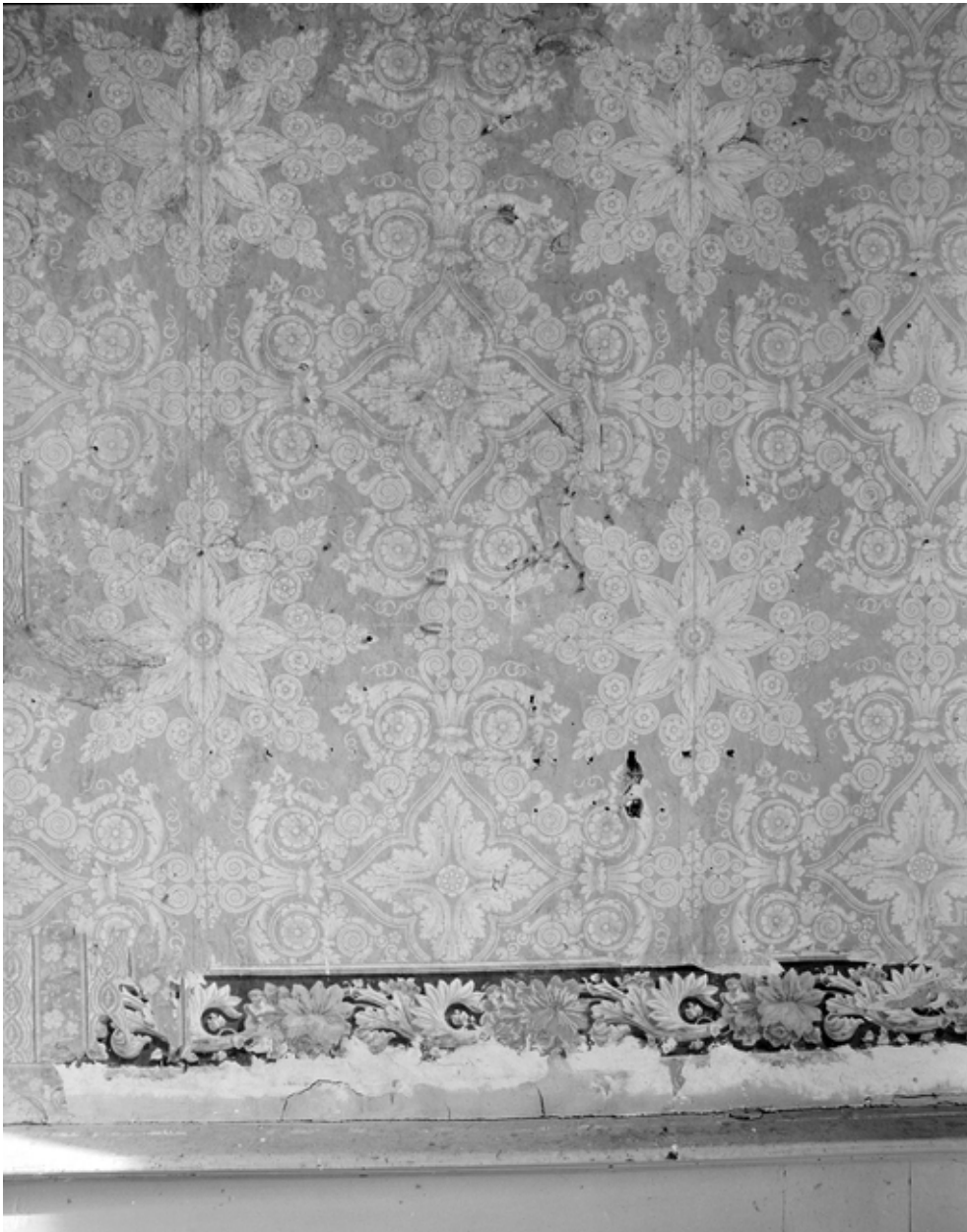
Premier étage, chambre nord n°1, mur ouest, vestiges du papier peint.
